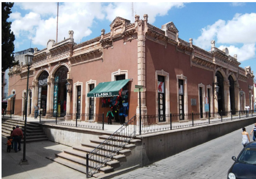
Figura 6. Mercado Juárez (Miranda Méndez, 2016-1). En las obras de adaptación para transformarlo de mercado a centro comercial fueron respetadas las fachadas y los elementos estructurales.
