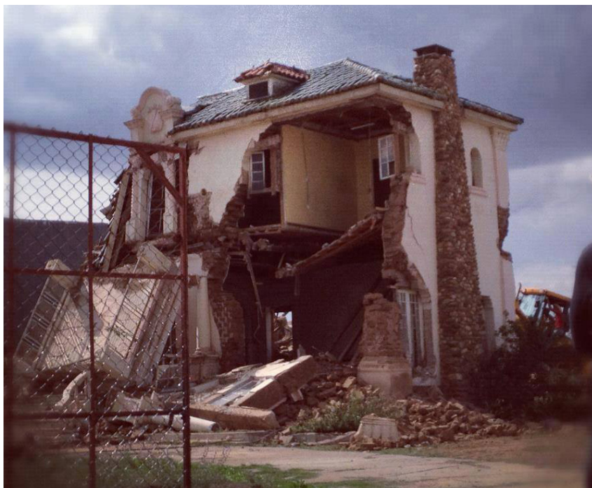
Figura 3. Las tareas de demolición (Fresnillo en el Tiempo, 2014). La obra que don Salomón construyó a lo largo de casi medio siglo, desapareció en el lapso de tres días.
