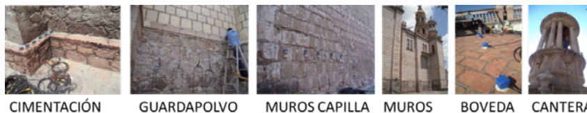
Figura 4. Identificación de los sistemas constructivos del Templo de San Antonio. Fuente: Elaboración propia.
