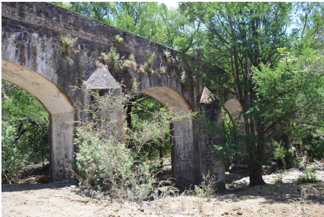
Figura 1. Acueducto Las Musas, perteneciente a la antigua hacienda de Atotonilquillo, municipio de Manuel Doblado, Gto. Fuente: MENR.
