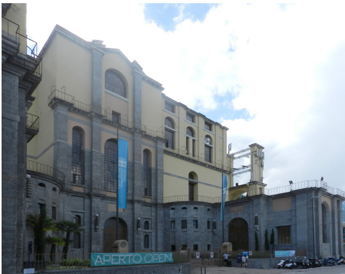
Fig. 5. Centrale del Ponale, Riva del Garda (Trento, Italia). Particolare della facciata della centrale (foto Manuela Mattone).
