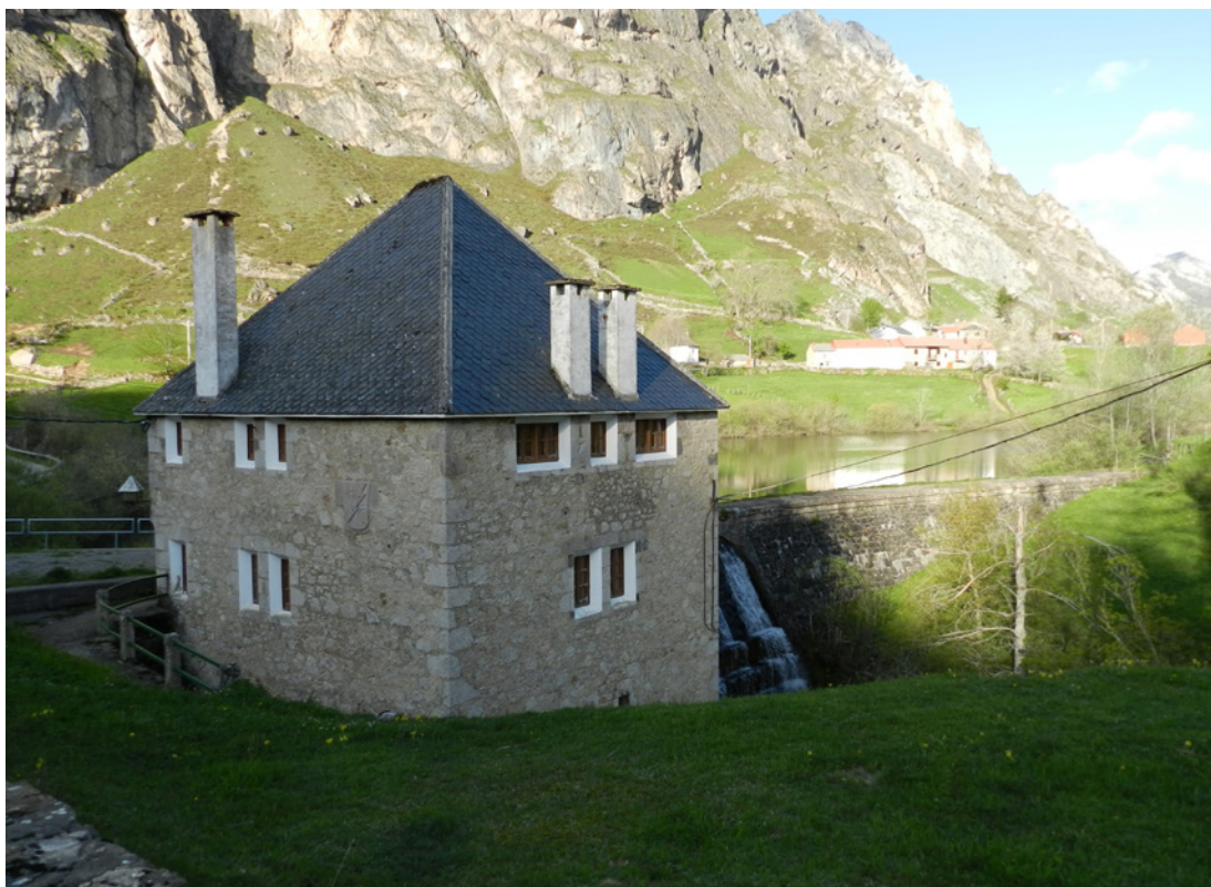
Fig. 9. Patrimonio dell'idroelettricità: lo sbarramento e la casa del custode a Valle del Lago (Asturias, Spagna) (foto Manuela Mattone).
