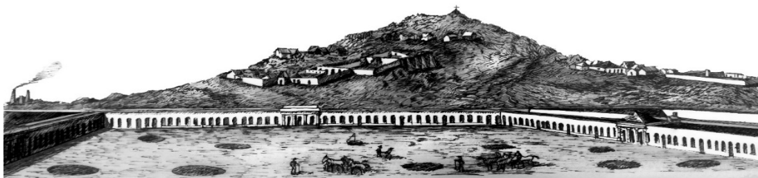
Figura 1. Bosquejo del autor basado en la lámina del “Museo Mexicano” de 1843 que representa la instalación original de la Hacienda Nueva. Al centro, las labores de beneficio de la plata por el método de patio.
