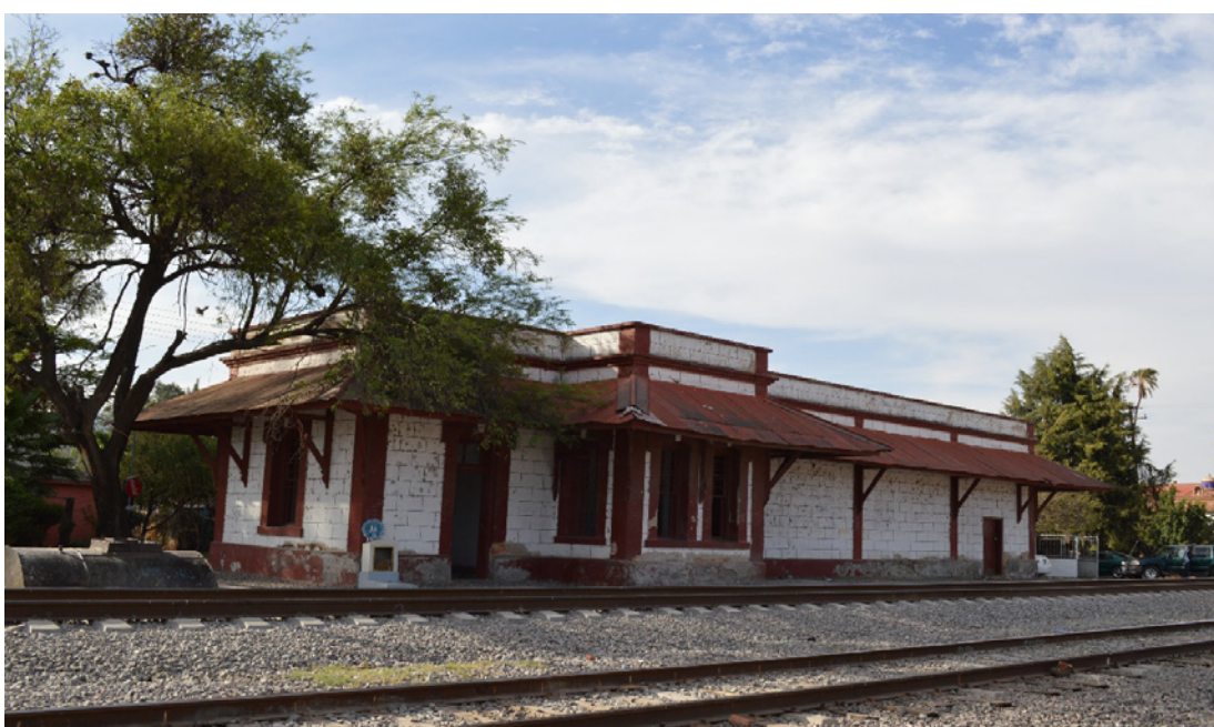
Figura 3. Estación de Carralejo actualmente. Fuente: M.EN.R.
