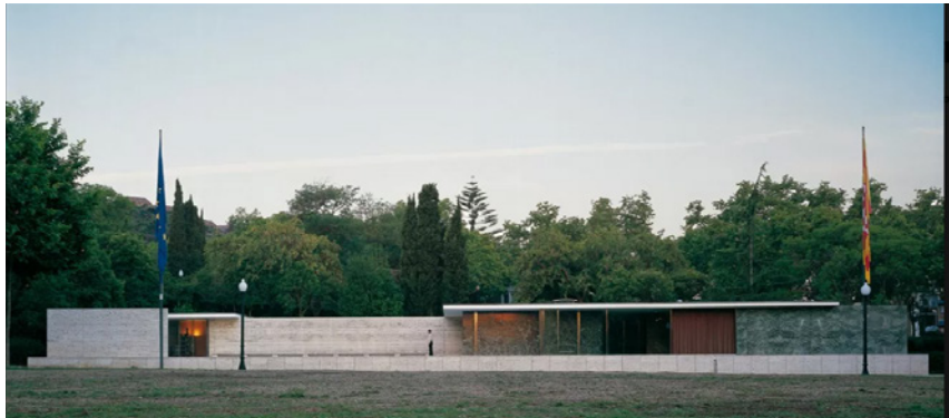
Figura 2. Pabellón de Alemania para la exposición Internacional de Barcelona de 1929 por Ludwig Mies van der Rohe. Fotos © Pepo Segura. http://miesbcn.com/es/el-pabellon/
