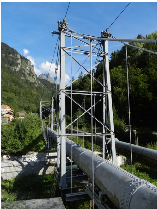
Fig. 8. Patrimonio dell'idroelettricità: le condotte forzate della centrale di Pralognan (Savoia, Francia) (foto Manuela Mattone).
