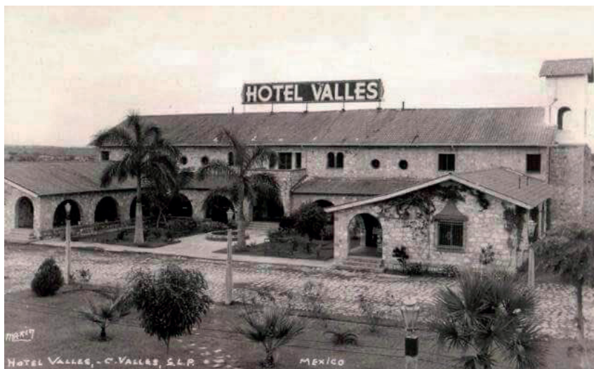
Figura 19. Hotel Valles, construido en 1953, publicidad en tarjetas postales de la época. Fuente: Archivo Catherine Ettinger .
