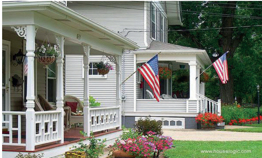
Figura 2. Casa de madera tipo estadounidense 5
