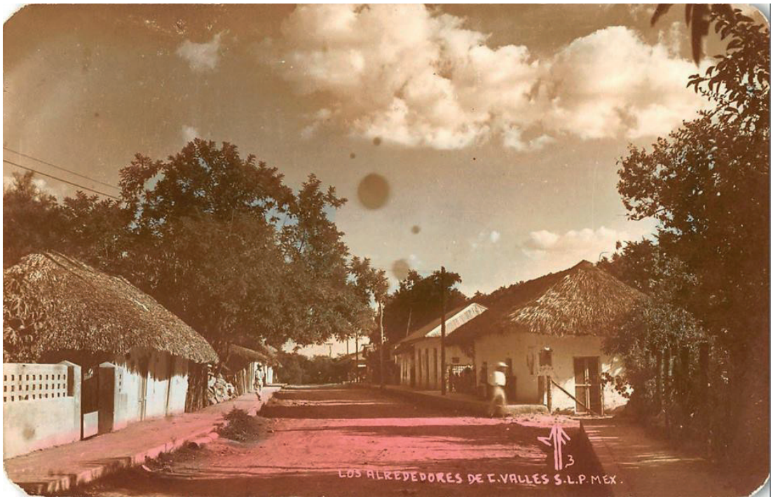
Figura 10. Viviendas típicas de Valles en 1935. Tarjeta postal promoviendo el lugar. Fuente: Archivo Catherine Ettinger.
