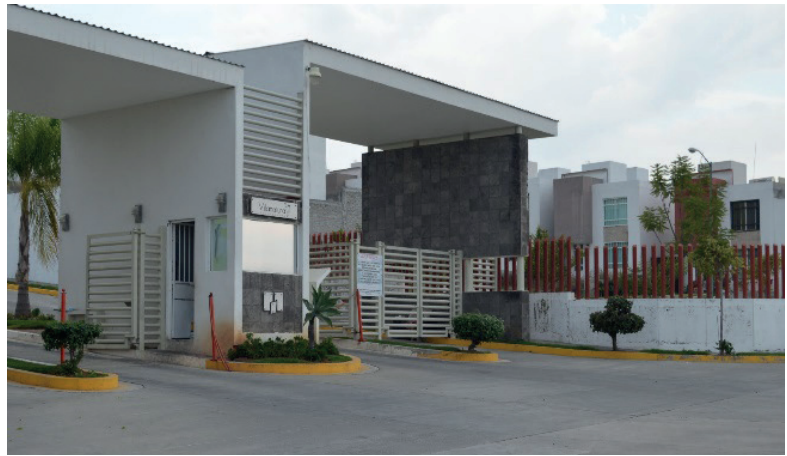
Figura 15. Acceso Fraccionamiento Villa Natura. Fotografía del autor.
