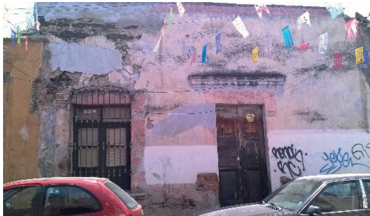
Figura 8. Inmueble ubicado en 16 de Septiembre No. 136, Centro Histórico, Querétaro.
