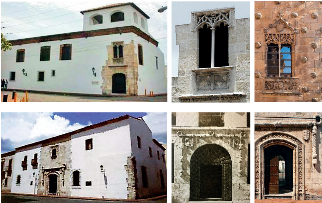
Figura 7. Similitud en el detalle. Arriba: Ventana geminada en casa de Francisco Tostado y en Casa de las Conchas, España. Abajo, casa de los Dávila o Casa del Cordón con Casa del Cordón (actual Museo de Palencia, España). Fotos J. Urrea, p. 115. Fotos locales del autor.
