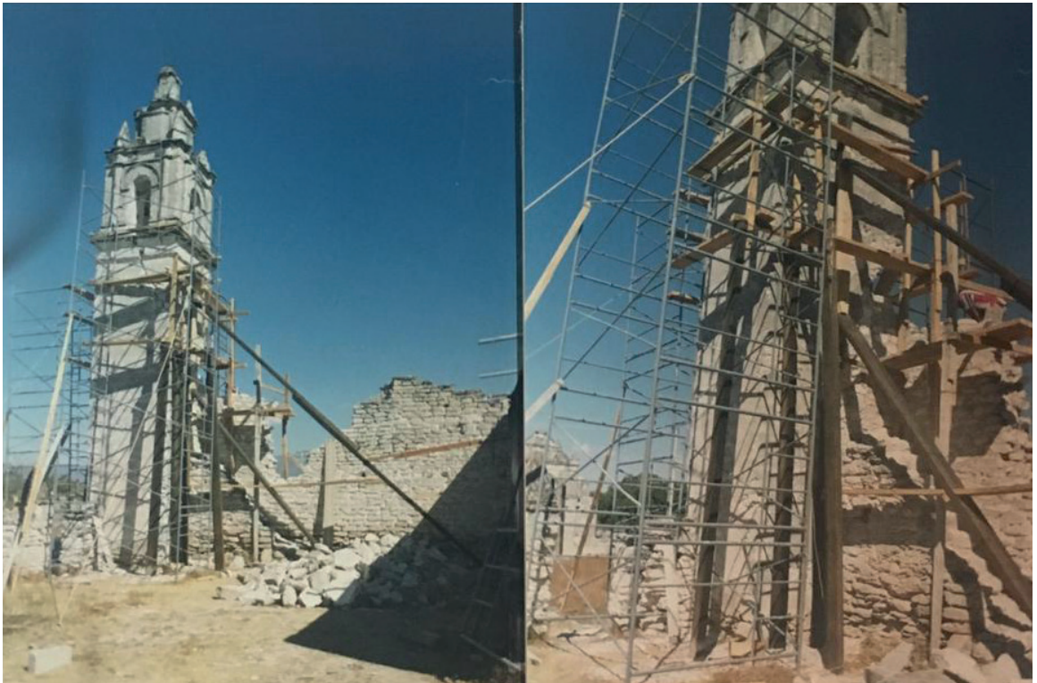
Imagen 10. Sismo Santa María Coacucán 1999, proceso de obra. Foto Archivo Centro INAH Puebla.
