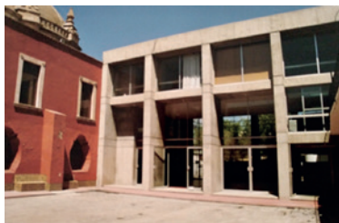
Imagen 111. Segundo patio y Edificio Polivalente. Fuente: Fotografía particular.
