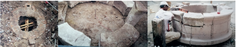
Imágenes 125, 126 y 127. Localización del brocal del pozo, recuperación de piezas y restitución de las faltantes para completarlo.
