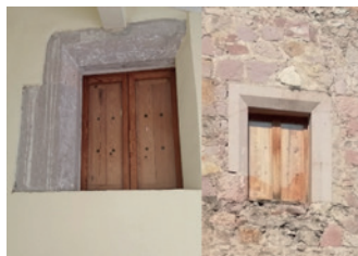
Imágenes 11 y 12. Ventana en el primer acceso de la escalera hacia las celdas del claustro alto, igual a las recuperadas en la fachada oriente hacia los corrales y la huerta, hoy al segundo patio del Museo Nacional de la Muerte o Edificio 19 de junio. Fuente: AJLGR.
