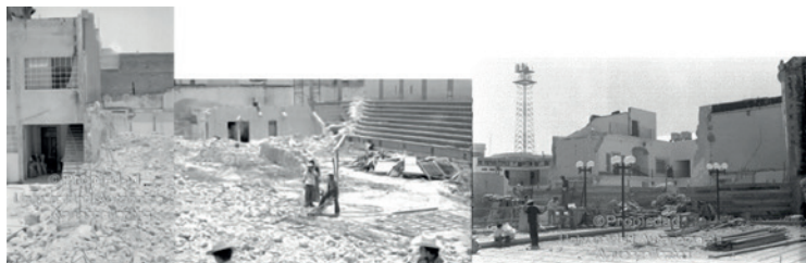
Imágenes 103, 104 y 105. Demolición de la Cancha del Estado y aulas del tercer patio. Fuente: Fototeca UAA.
