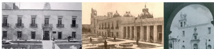
Imágenes 78, 79 y 80. Fotografías de la Escuela Preparatoria. Fuente: AHEA.
