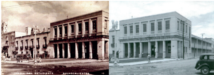
Imágenes 152 y 153. Fotografías de la Escuela Preparatoria. Fuente: AHEA.
