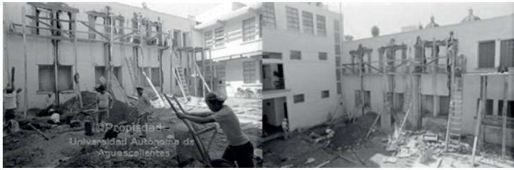
Imágenes 106 y 107. Modificación de la planta alta del edificio “J. Gómez Portugal” hacia el patio principal del edificio “19 de Junio”.
