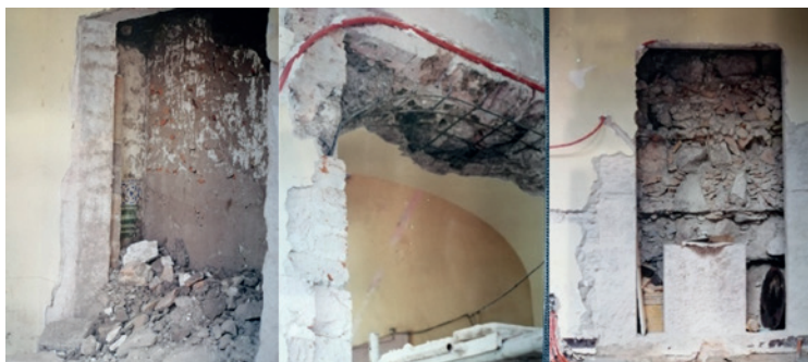
Imágenes 134, 135 y 136. Localización de enmarcamientos desbastados, tapiados y modificados. Fuente: AJLGR.
