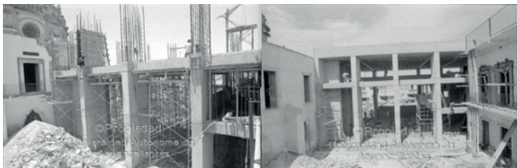
Imágenes 101 y 102. Construcción del Edificio Polivalente. Fuente: Fototeca UAA.
