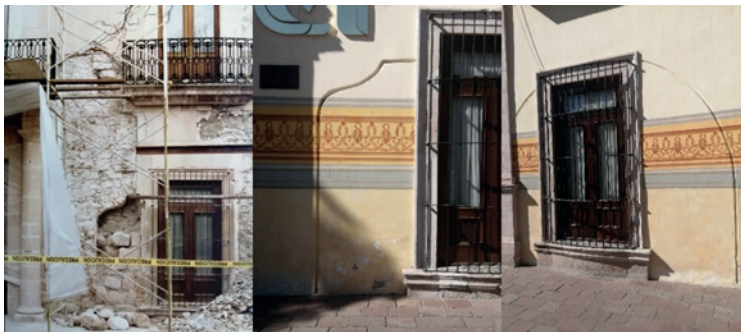
Imágenes 119, 120 y 121. Detección del acceso de la “Escalera Magna” dieguina hacia la planta alta y la hendidura que se dejó en fachada como evidencia al igual que uno de los arcos del Portal de Peregrinos. Fuente: AJLGR.
