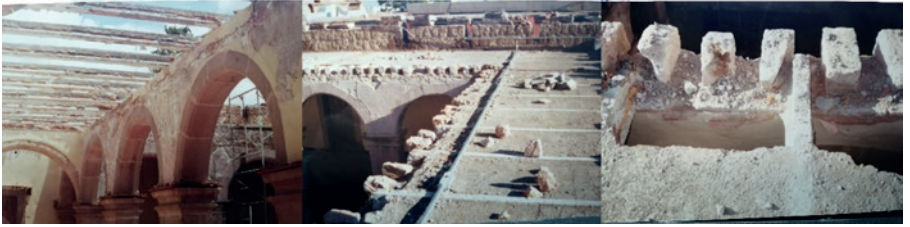
Imágenes 122, 123 y 124. Eliminación de rieles metálicos y bóveda de ladrillo, lo que permitió encontrar los huecos originales de las vigas o “mechinales”, obteniendo su dimensión para volverlas a restituir.
