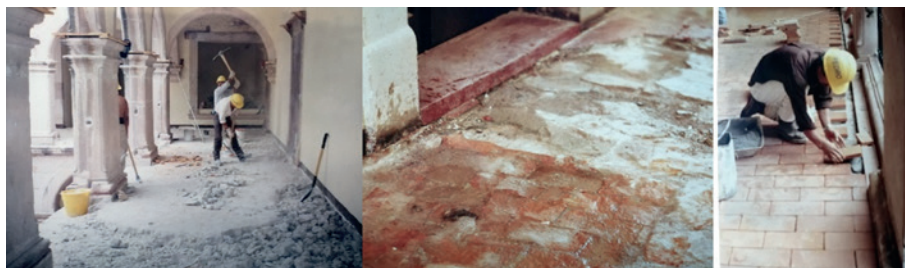
Imágenes 131, 132 y 133. Eliminación de pisos de mosaico de cemento, localización del piso original y restitución de la baldosa de barro.
