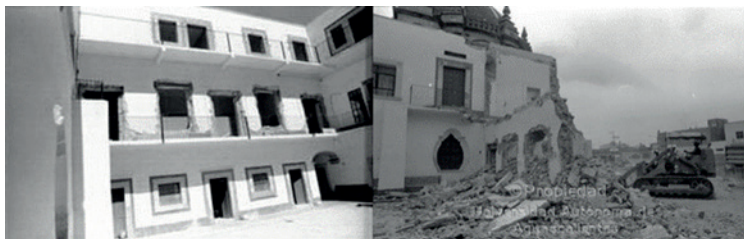
Imágenes 97 y 98. Demolición de los tres niveles de aulas del segundo y tercer patio. Fuente: Fototeca UAA.
