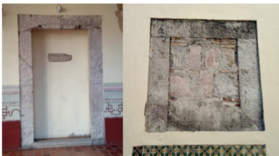
Imágenes 13 y 14. Acceso desde el claustro y ventana al segundo patio de la Sala de Profundis. Fuente: AJLGR.
