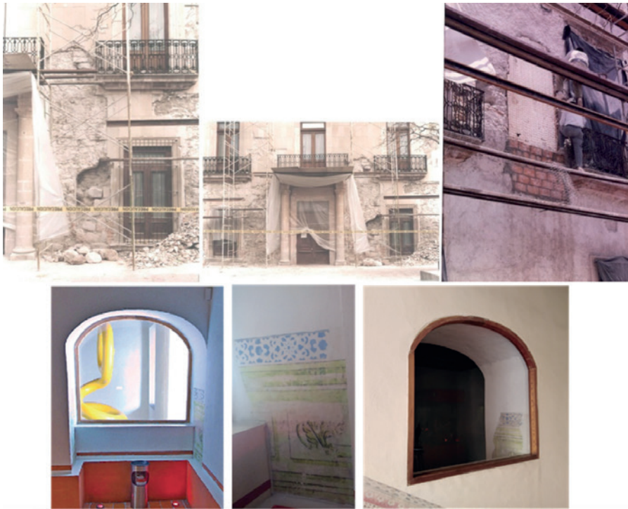
Imágenes 20, 21, 22, 23, 24 y 25. Evidencias del paso de la Escalera Magna antes de su demolición al Claustro anterior o Paso de Celdas, vigente por la ornamentación decimonónica en la primera etapa del Instituto Científico y Literario, antes de que se le diera forma a la fachada actual. Fuente: AJLGR.
