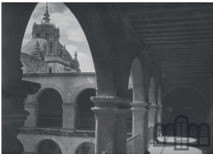
Imagen 84. Claustro del Instituto de Ciencias con su viguería original antes de la sustitución de la misma por rieles y bóveda de ladrillo. Fuente: AHEA.
