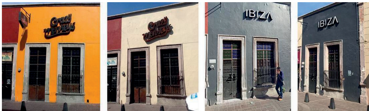
Figura 2. Misma fachada con diversos cambios en el exterior. Las dos primeras fotografías de la izquierda son del 2016, mientras que las dos siguientes son del 2021. Se aprecia el cambio de nombre e identidad. Ubicado en Calle Carranza 207, Centro Histórico de Aguascalientes. Fotografías: De La Barrera, 2016 y 2021.
