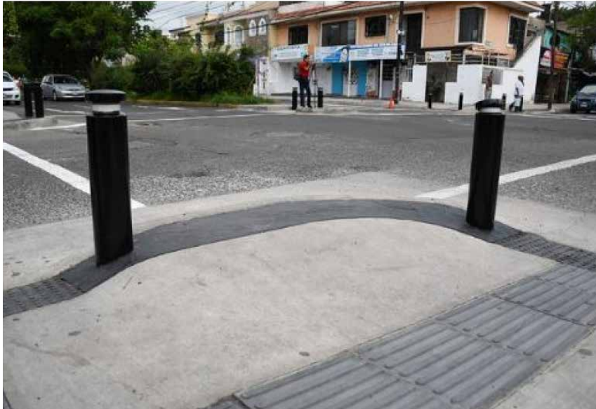
Imagen 22. Banquetas correctamente acondicionadas
