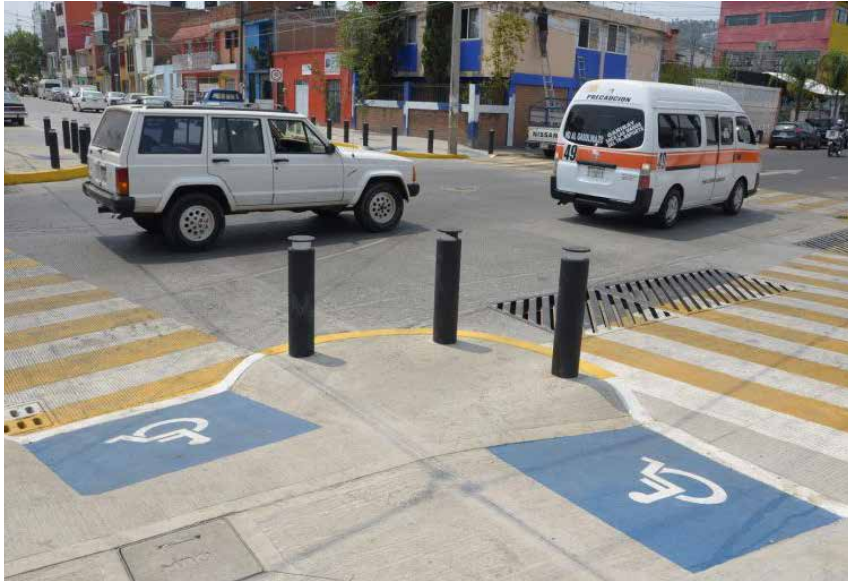
Imagen 18. Remodelación de cruces atendiendo a recomendaciones de accesibilidad universal
