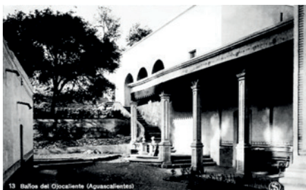
43. Baños Grandes de Ojocaliente, ca. 1900.
