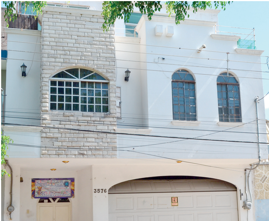
Fotografía 20. Vivienda de mejor apariencia en la Hermosa Provincia.
