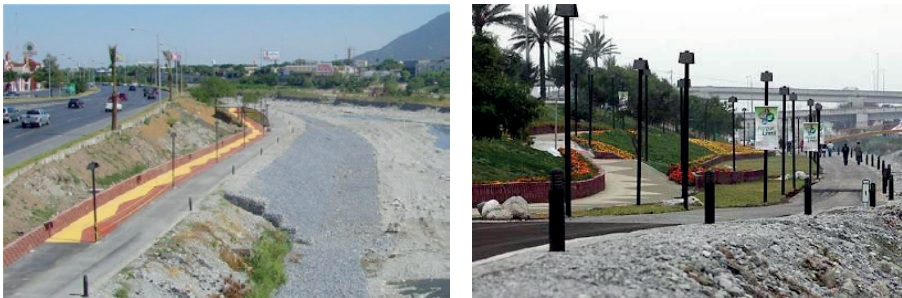
Figura 4 y 5. Parque lineal Río Santa Catarina, Monterrey, Nuevo León, México. Fuente: García (2006).
