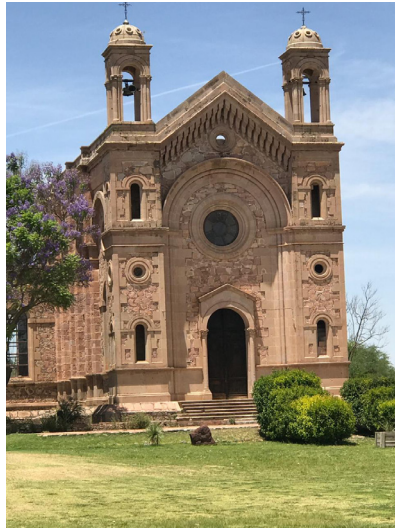
Figura 59. Fotografía del templo de la Hacienda de Garabato, construido en 1895, posiblemente por el arquitecto empírico Refugio Reyes Rivas, dedicado a San Isidro Labrador, es de estilo neorrománico, con arcos de medio punto, archivolta, el remate del techo de dos aguas y dos torres gemelas de un solo cuerpo. Imagen proporcionada por la Dra. Marcela López Arellano en 2022.
