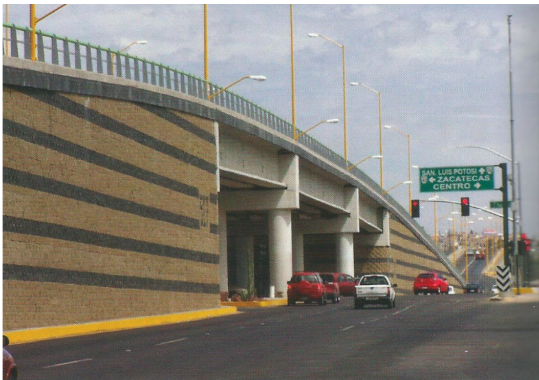
Figura 4. Boulevard a Zacatecas y avenida Aguascalientes. Fuente: Espinoza, T. J. (2010). Vamos por el camino adecuado. Construye Aguascalientes. Revista oficial de la cámara de la industria de la construcción , 4(27).
