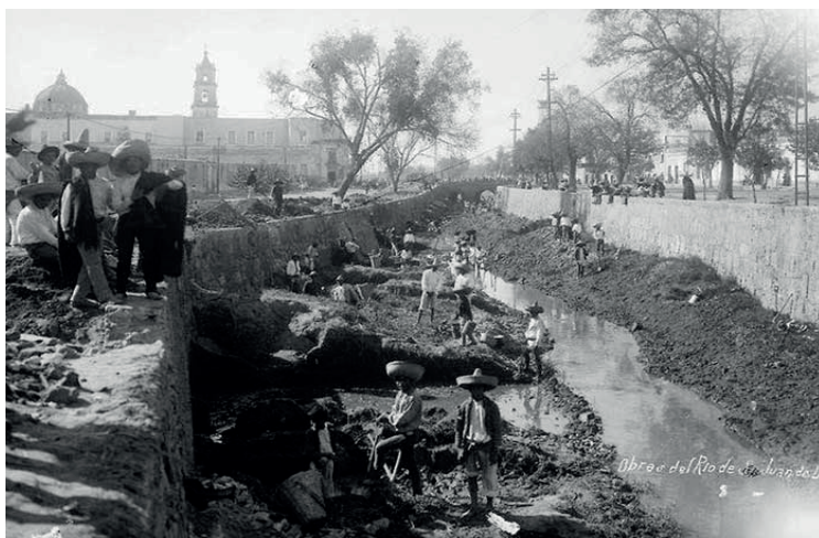
Ilustración 3. Obras de entubamiento en el río San Juan de Dios en 1890 18
