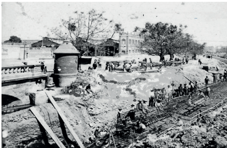
Ilustración 2. Obras de entubamiento del río San Juan de Dios en 1890
